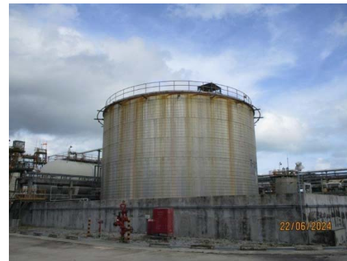
รูปที่ 40 คันคอนกรีตรอบถังกักเก็บสารเคมี
