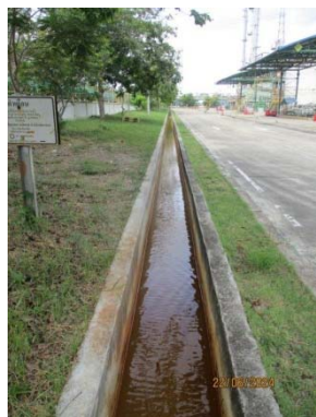
รูปที่ 12 รางระบายน้ำฝนภายในพื้นที่โรงงาน ที่แยกออกจากรางระบายน้ำเสีย
