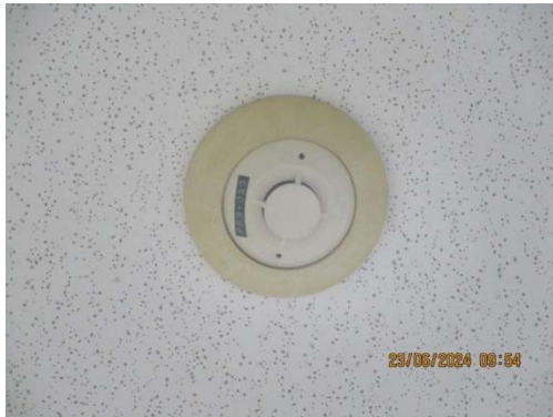
รูปที่ 53 Smoke Detector
