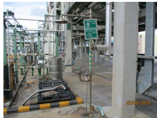
รูปที่ 44 อ่างล้างตาและร่างกายฉุกเฉิน
