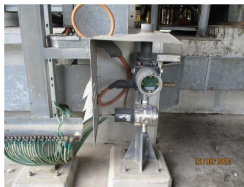
รูปที่ 52 Gas Detector
